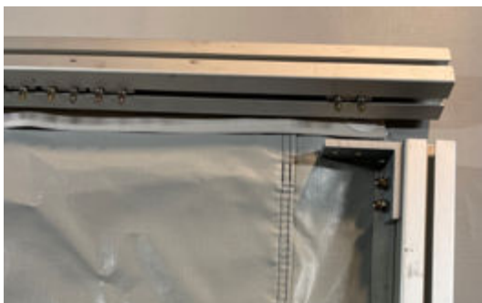
*4 - För att fästa D- och E-vinklarna behöver du böja överliggaren så att den hamnar rätt.
