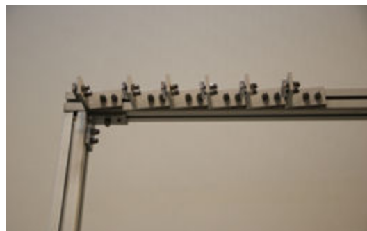
*8 - Förbered 13 C-vinklar inför kommande takstolar.
