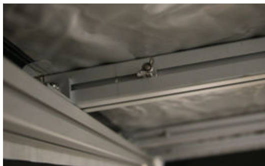
*3 - Gå in i tältet och löst skruva fast T-skruv i mutterbrickorna.
