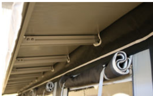
*1 - Justera takstolar och B-vinklarna på frontväggens överligger efter avsedda hål i taket.
